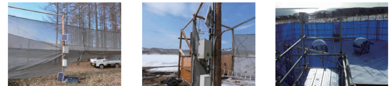
ソーラー電源による稼働
