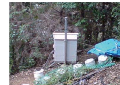
斜面崩壊観測設備
