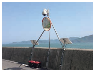
海岸沿い道路の地すべり監視
