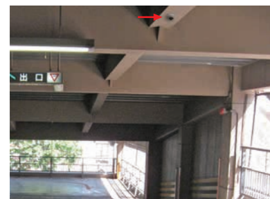
屋内駐車場の監視
