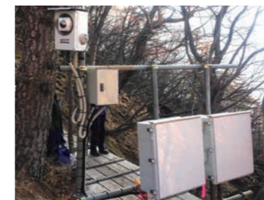
監視カメラシステム
