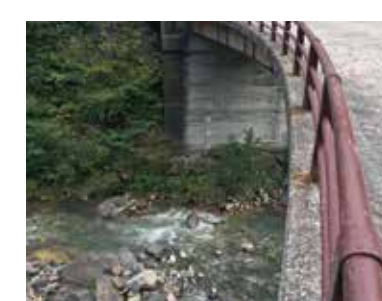
河川設置箇所
