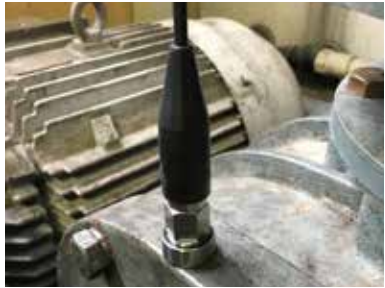
振動ピックアップ取付部
