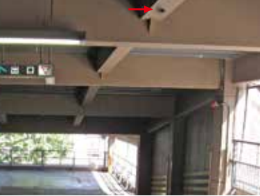
屋内駐車場の監視
