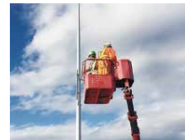
高所作業の監視
