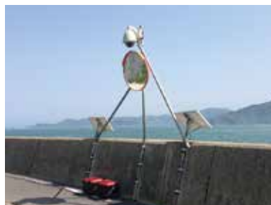
海岸沿い道路の地すべり監視
