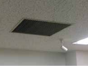
オフィスエントランスの監視
