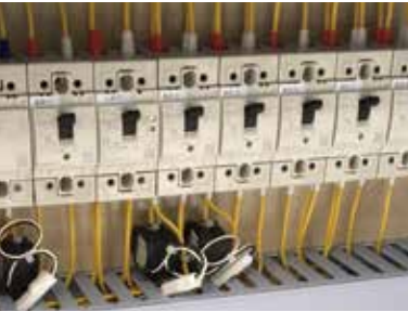
ブレーカーの電流値計測
