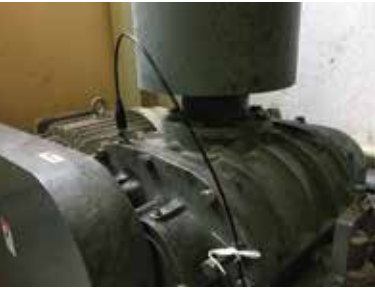
振動ピックアップ設置の様子
