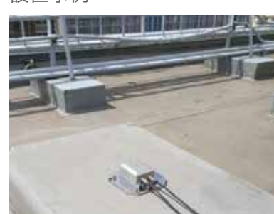
高層ビルのヘルスマニタリング
